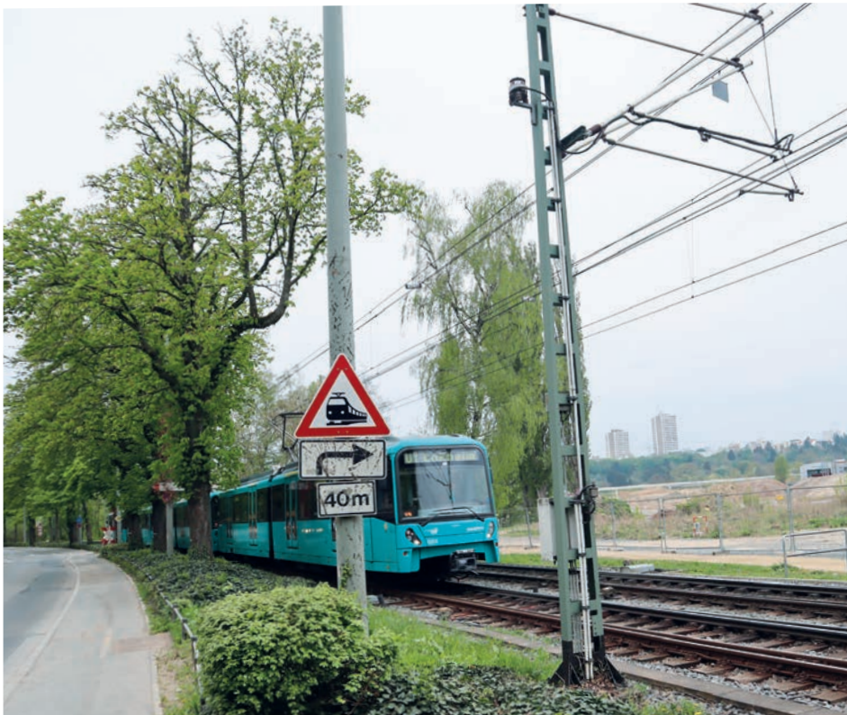
Hinter den Gleisen werden die Rampen zur A661 sowie Tunnelöffnung entstehen. Foto: privat
