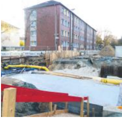
Autobahnbau: Baustelle im November 2020.
