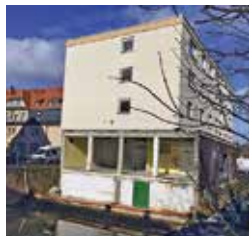
Was wird aus der Baustelle in der Rümelinstraße?
