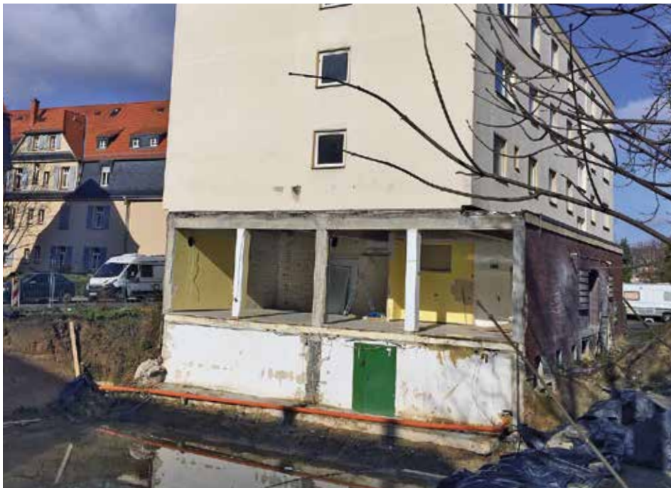
Baustelle in der Rümelinstraße.
