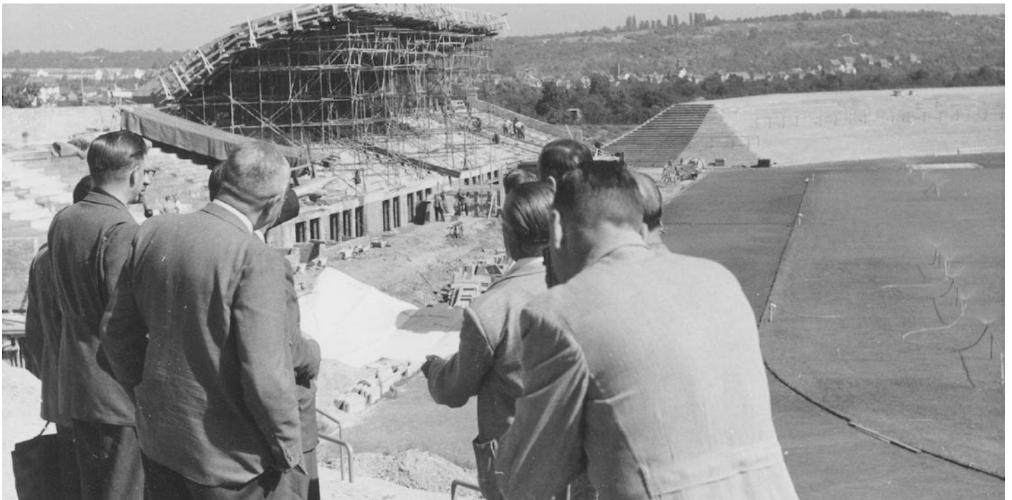
Riederwaldstadion der Eintracht Frankfurt, 1952
