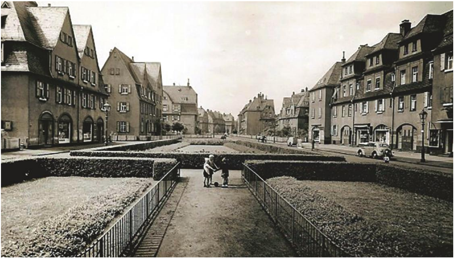
Blick von der Ladenzeile in die Max-Hirsch-Straße
