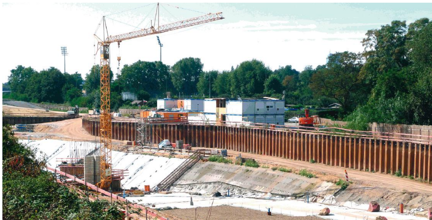
Baustelle am Erlenbruchdreieck, September 2015
